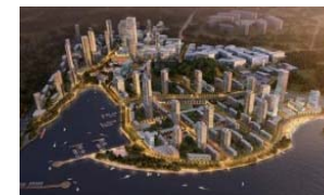
大連ソフトウェアパーク2期 ・遼寧省大連市 ・2014年10月全体竣工 ・住宅1,900戸/商業施設床面積47,000㎡
