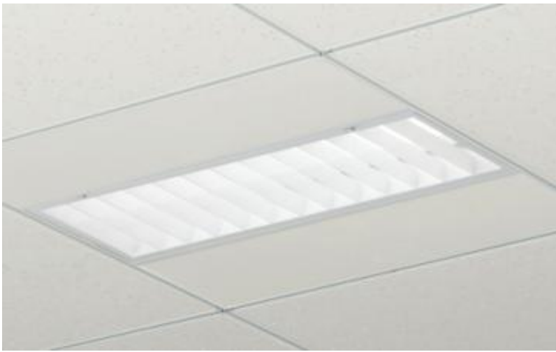
グリッド式システム天井に設置した状態
