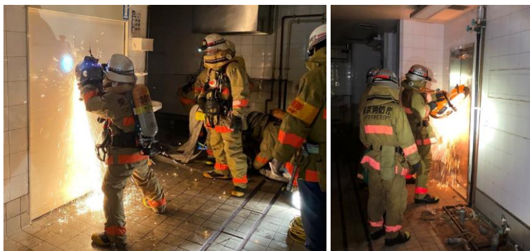
エンジンカッターによる開口・破壊訓練
