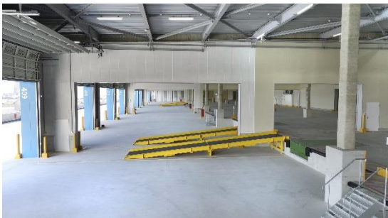
< 45ft コンテナ車両対応トラックバース >
