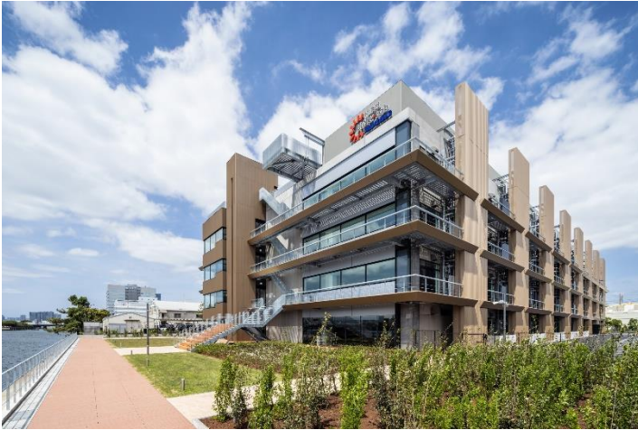
「三井リンクラボ新木場 2」外観(南東側)
