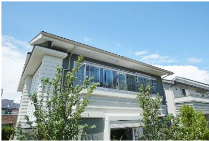
【本モデルハウスバルコニーに設置のペロブスカイト太陽電池写真】
