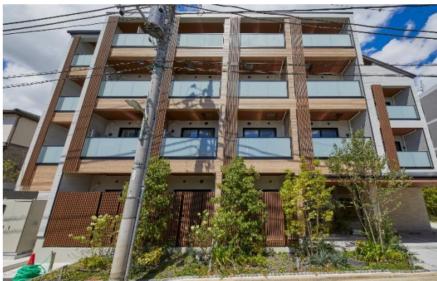
【バルコニースラブ・縦ルーバー】
