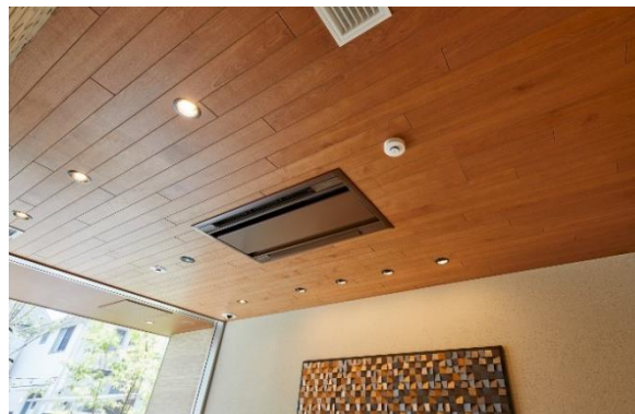
【共用ラウンジ天井】
