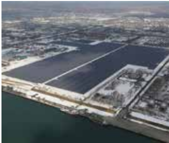
兆瓦级光伏发电项目(北海道苫小牧市)
