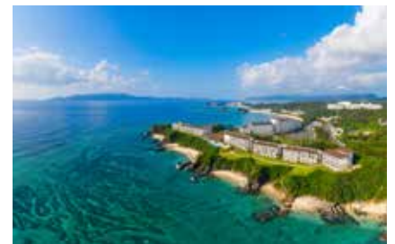
Halekulani冲绳 沖縄県国頭郡恩納村(2019年7月开业, 360间客房)
