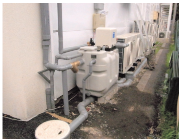
「パークシティ国分寺」販売センターの 雨水貯留槽
