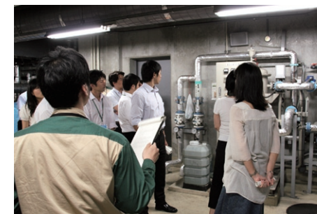
館内エコツアーでの雨水ろ過装置の見学
