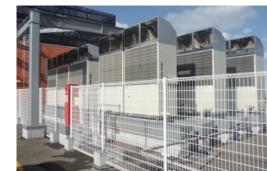
「三井アウトレットパーク札幌北広島」の 発電機能付きガスヒートポンプ室外機
