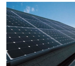
「屋根据置型」太陽光パネル
