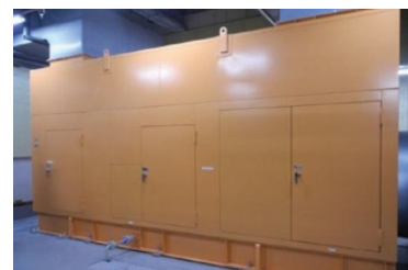
非常用発電機
