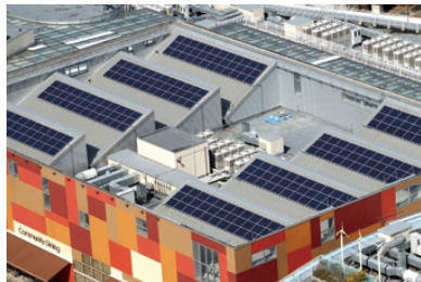
「ららぽーと柏の葉」の増設した太陽光パネル
