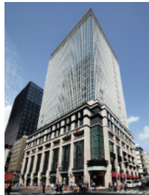
COREDO室町 (2010年竣工)
