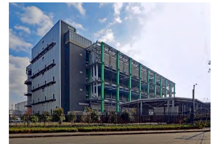
データセンター MFIP印西II
