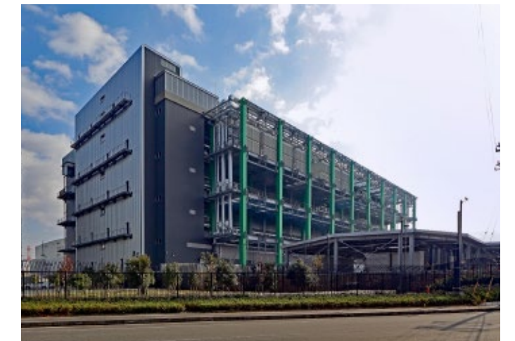
データセンター MFIP印西II
