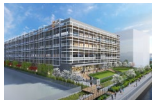
● (仮称)三井リンクラボ東陽町1
