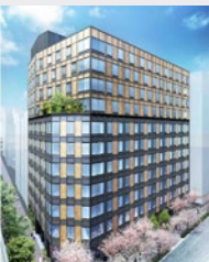
(仮称)日本橋本町一丁目5番街区
