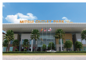
三井アウトレットパーク クアラランプール国際空港 セパン
