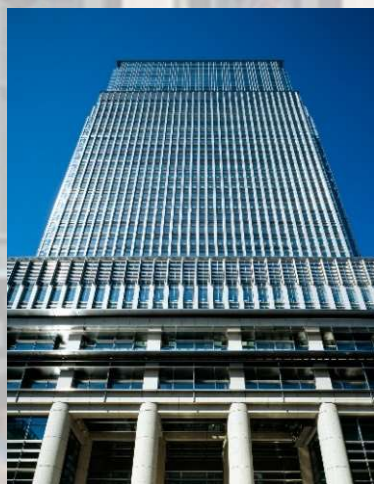
日本橋三井タワー 竣工
