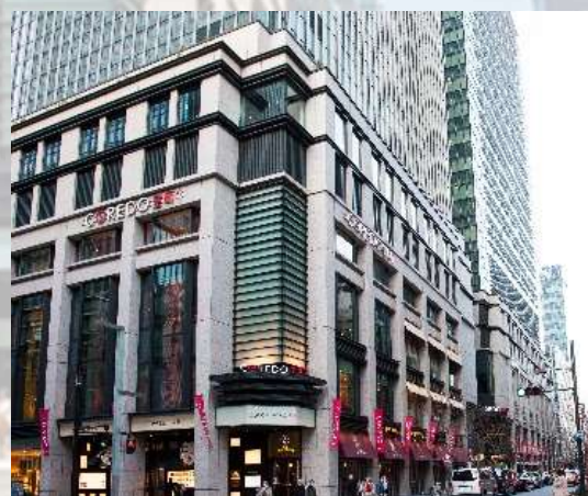
室町東三井ビルディング 竣工 コレド室町1 開業
