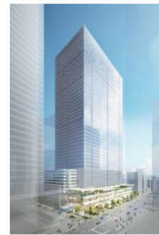
八重洲二丁目中地区 (2028年度 竣工予定)
