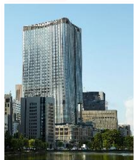
東京ミッドタウン日比谷 (2018年 竣工)
