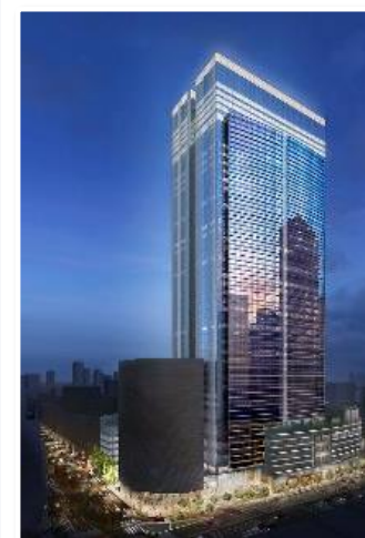
八重洲二丁目北地区 (2022年8月 竣工予定)
