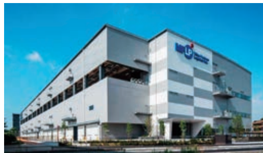
「三井不動産ロジスティクスパーク大阪交野」 (大阪府交野市)
