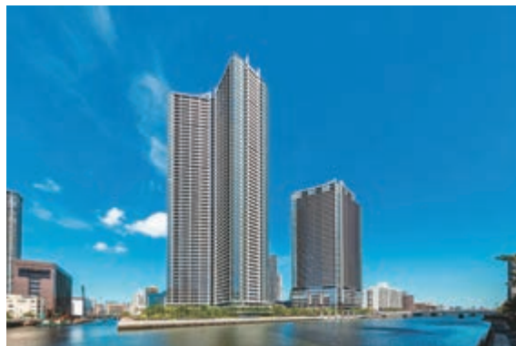
「パークタワー勝どき ミッド／サウス」(東京都中央区)
