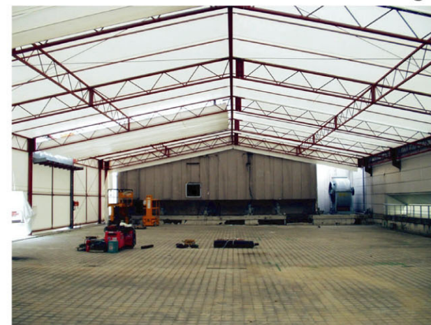
工事期間中の雨対策として仮設屋根が設営された
