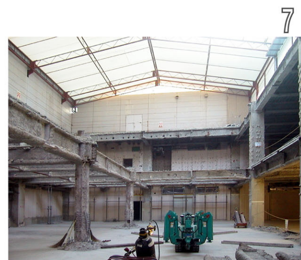
躯体解体が進み、シアター空間がイメージ可能となる
