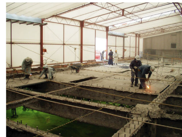
床の解体から進められ、仮設屋根は埃・騒音対策にも効果的であった
