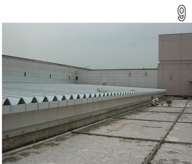
軽量化を図った折版屋根の施工
