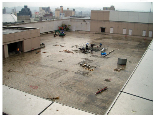
最初に設置されていた遊具等が撤去された
