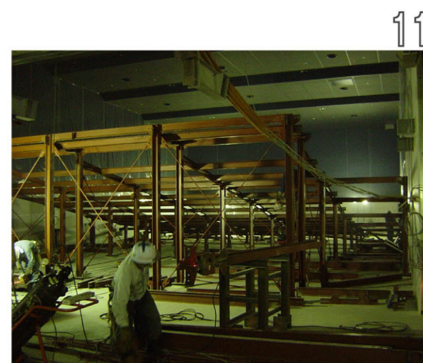
段床（シアター内の座席）の施工
