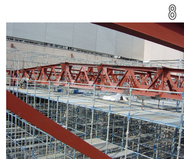
仮設屋根撤去と共に、鉄骨トラスの屋根を新設
