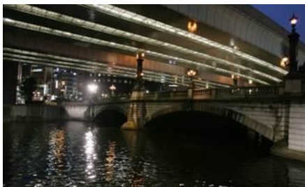
「日本橋」 ※初実施
