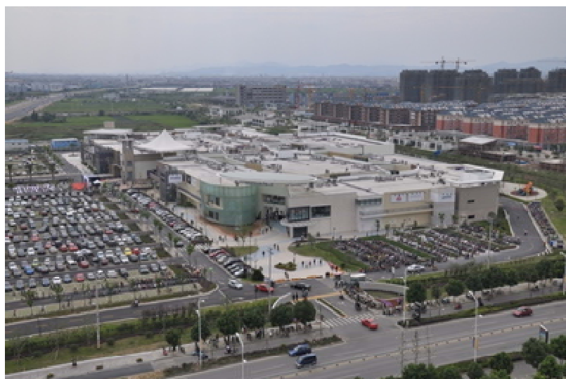
杉井アウトレット広場・寧波（外観写真）
