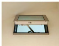
小屋裏収納の換気窓1 (2階廊下側の窓)
