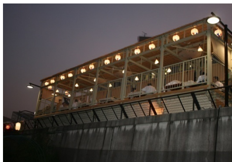
両国広小路栈敷 外観
