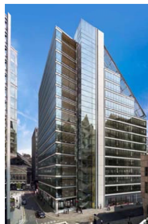
Mark Lane 開発計画 外観パース
