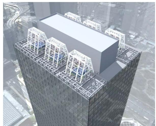
超大型制震装置TMD
