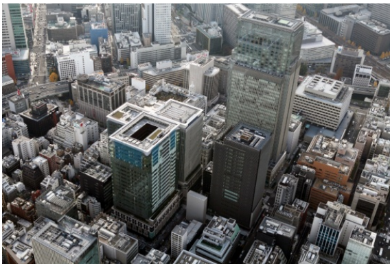
日本橋室町東地区開発計画（空撮画像）
