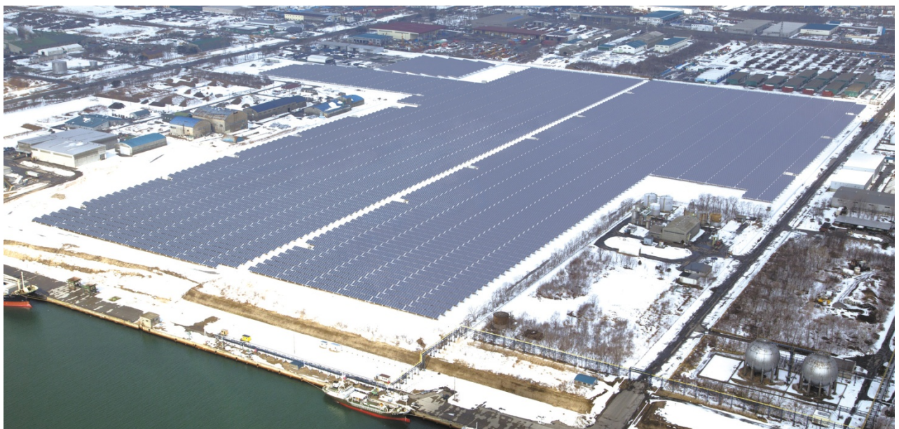
三井不動産苫小牧太陽光発電所 空撮写真
