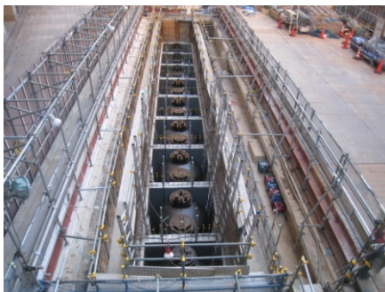
霞が関ビルディング オイルタンク増設工事
