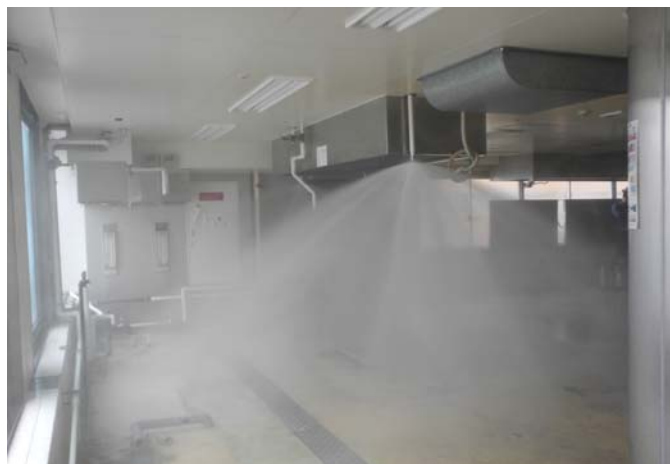
8/27 空きビルを利用したスプリンクラー作動訓練の様子
