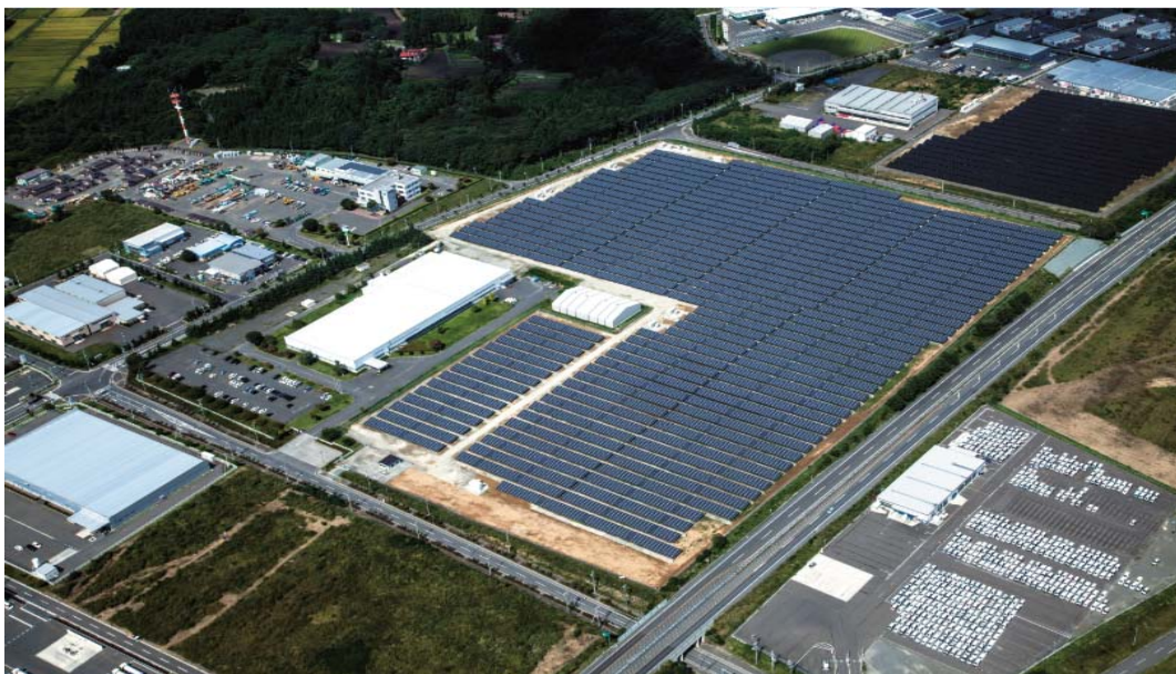
三井不動産八戸太陽光発電所 空撮写真
