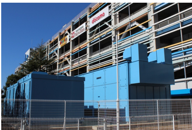
ららぽーと柏の葉に設置した NAS 電池外観
