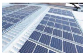
太陽光発電パネルの設置 屋上に100kw分を設置。
