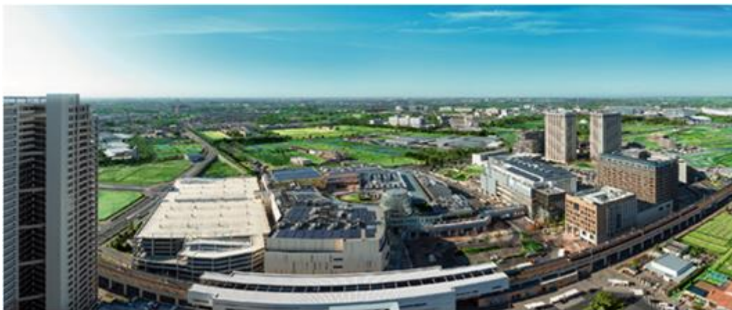
「柏の葉スマートシティ」全体外観（柏の葉キャンパス駅周辺）
