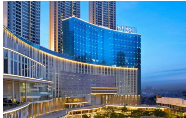
プルマン ジャカルタ セントラルパーク (インドネシア)
