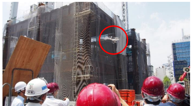
ドローンを使っての測量の様子
