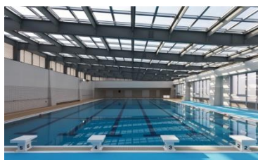
柏市立柏の葉小学校 プール
