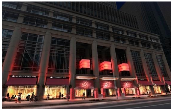
「日本橋三井タワー」
