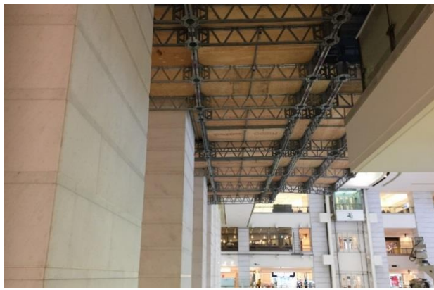
高天井耐震対策工事の施工中
