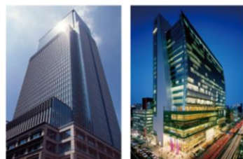
日本橋三井タワー
