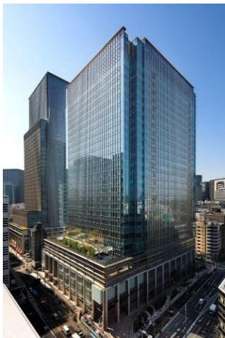
「日本橋室町三井タワー」
