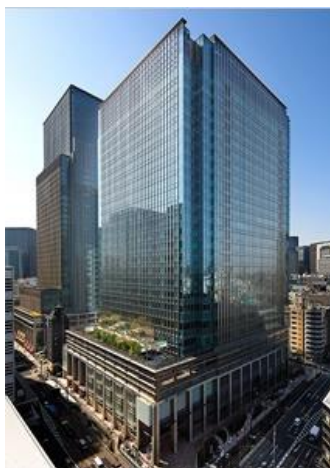
日本橋室町三井タワー
