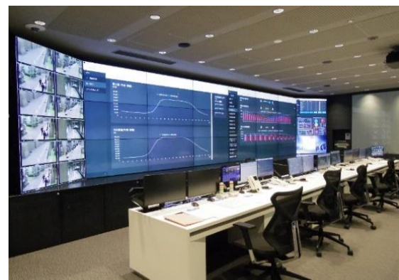
上 コ・ジェネレーションシステム
