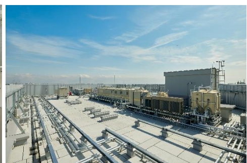
屋上スペース
