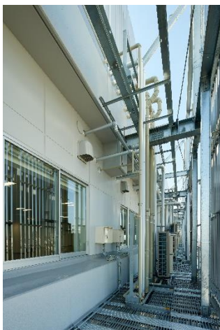
設備バルコニー
