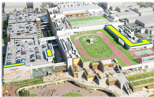
<太陽光パネル設置場所:黄色掛け部分>
