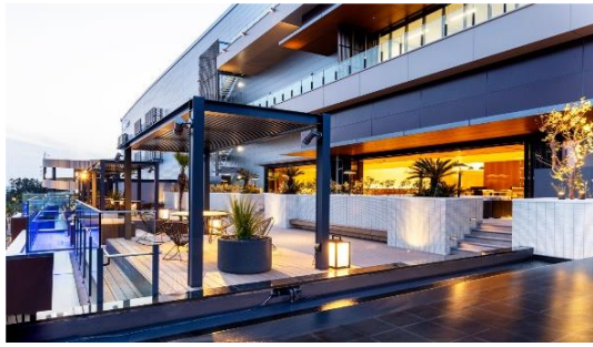
＜デッキテラス＞
