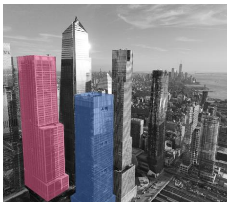
P1 掲載 ハドソンヤード全景
