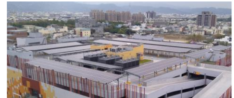
南館屋上の太陽光パネル
