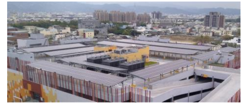
南館屋上の太陽光パネル
